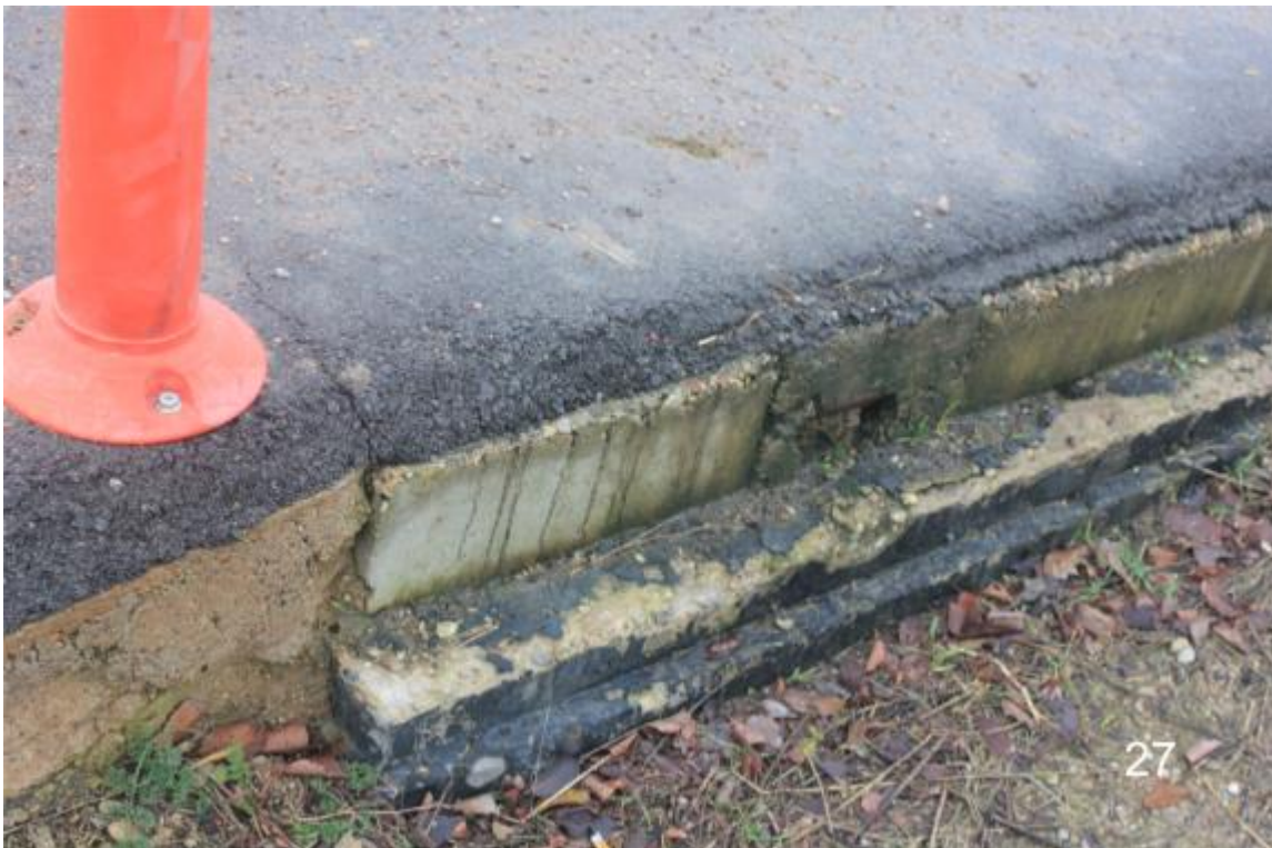
Vydutaičių tilto avarinės būklės stabilizavimas, panaudojant gelžbetonines konstrukcijas
