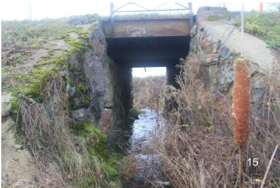
Vydutaičių tilto vaizdas iš Rytų pusės,
