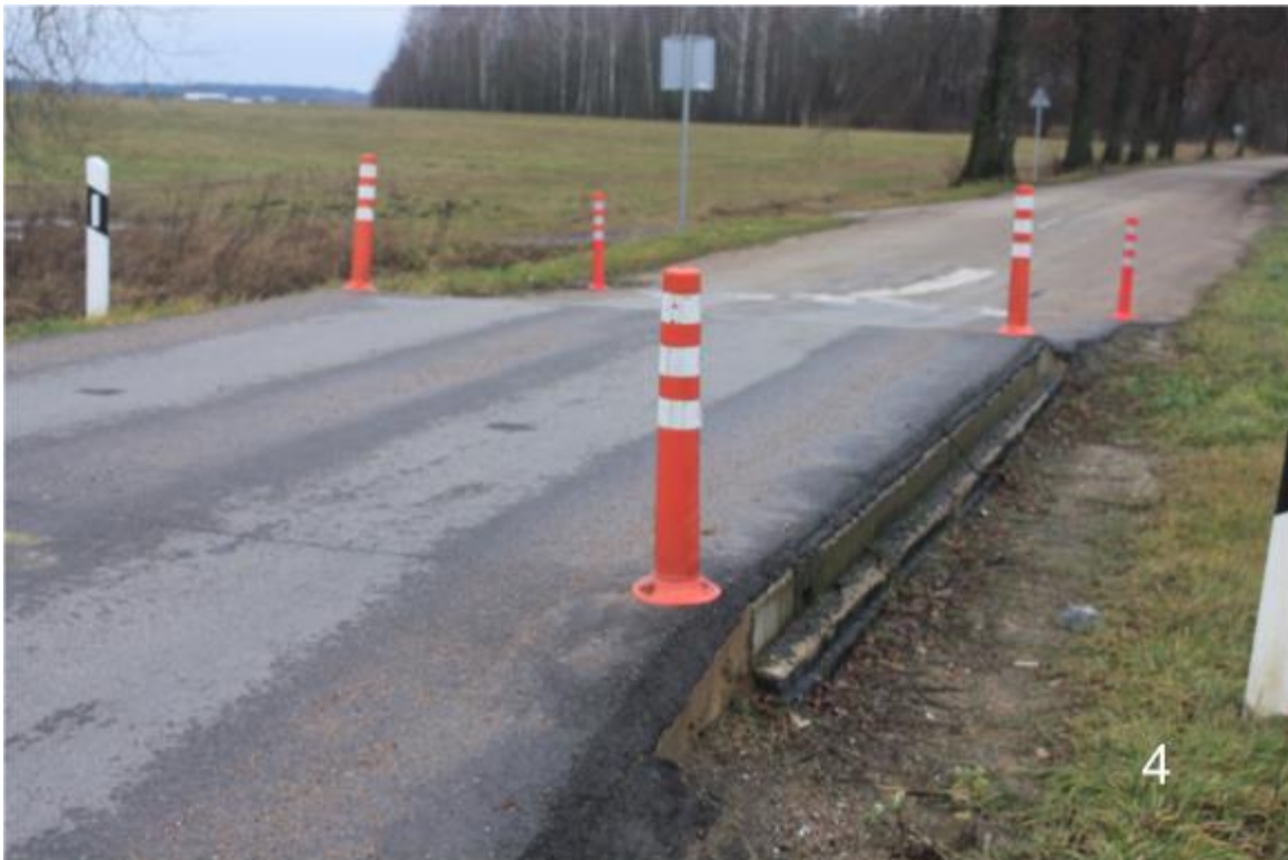
Vydutaičių tilto bendras vaizdas iš Pietų pusės
