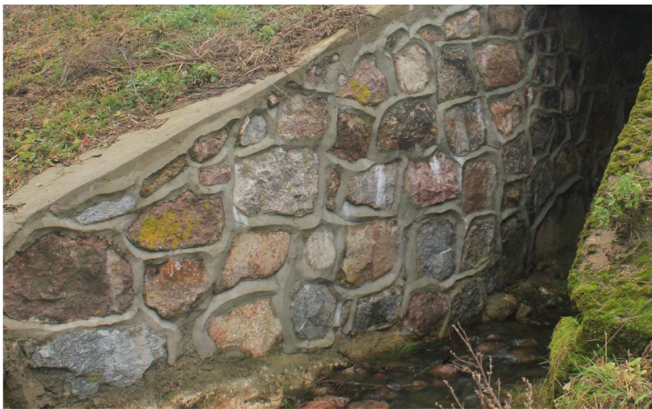
pav.7 Vydučiaių tilto (KVR u. k. 46984) akmenų mūro siūlių remontas (XX a. pab. XXI a. pr.)
