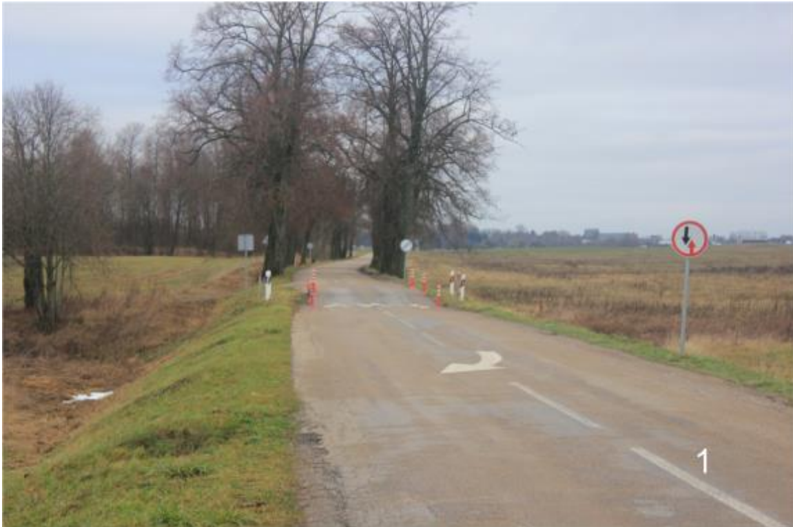
Vydutaičių tilto bendras vaizdas iš Pietų pusės
