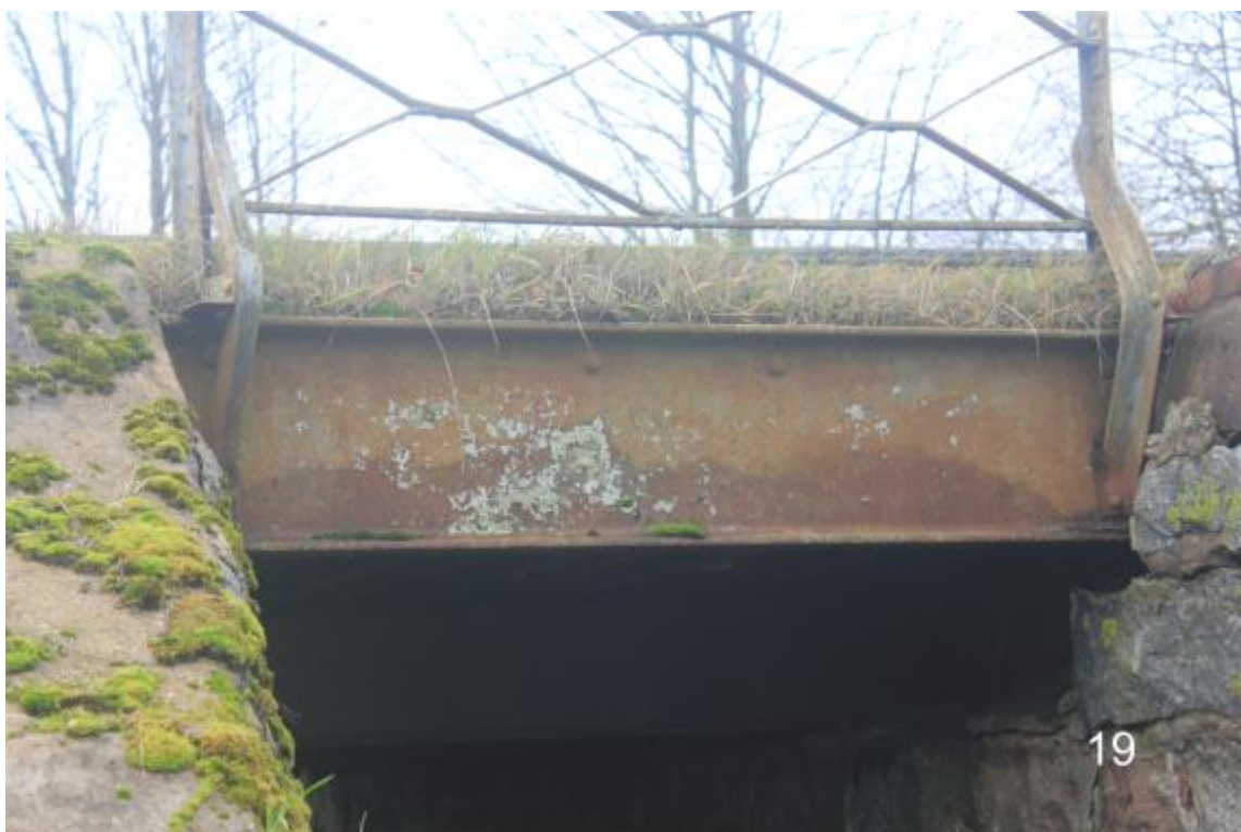
Vydutaičių tilto metalinė sija, vaizdas iš Rytų pusės,
