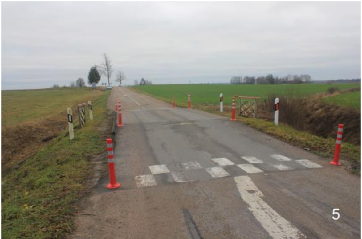
Vydutaičių tilto bendras vaizdas iš Šiaurės pusės
