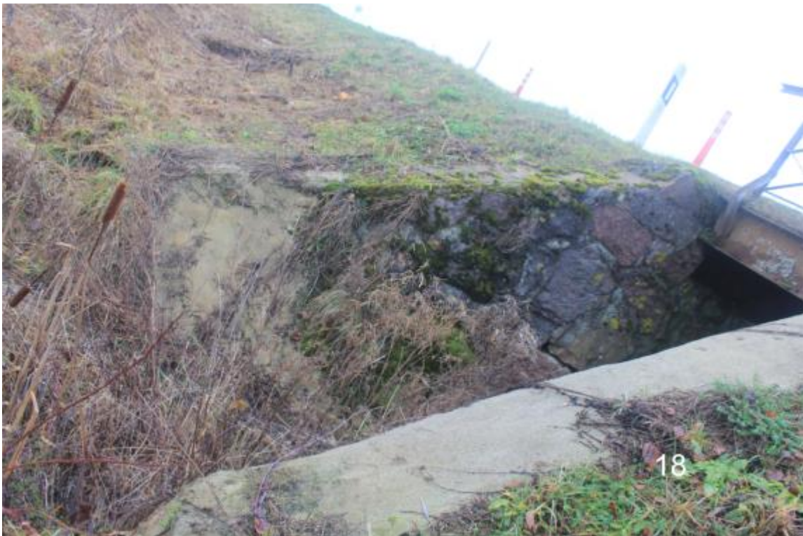
Vydutaičių tilto vaizdas iš Šiaurės Rytų pusės,
