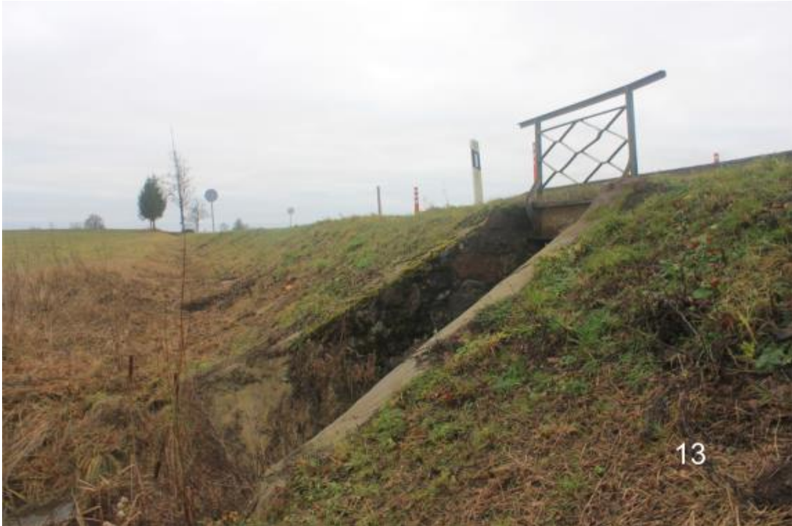
Vydutaičių tilto vaizdas iš Šiaurės Rytų pusės,
