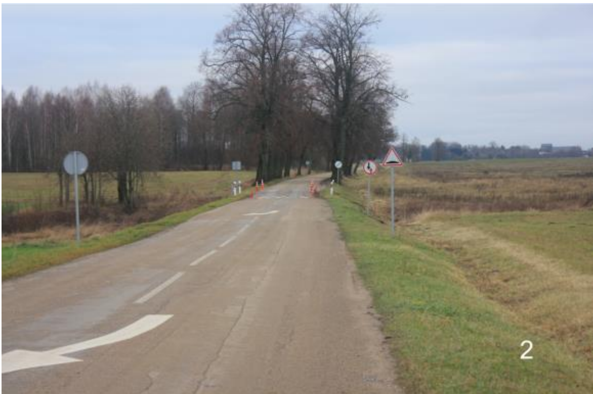
Vydutaičių tilto bendras vaizdas iš Pietų pusės
