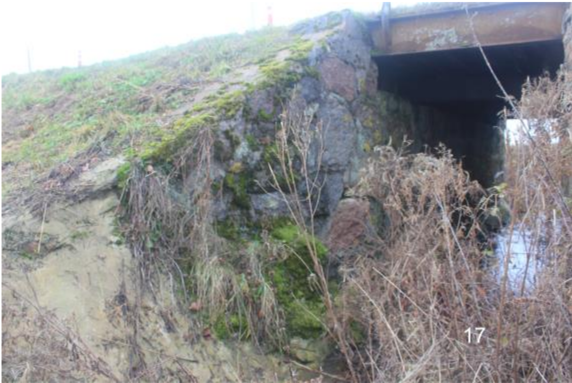
Vydutaičių tilto vaizdas iš Šiaurės Rytų pusės,
