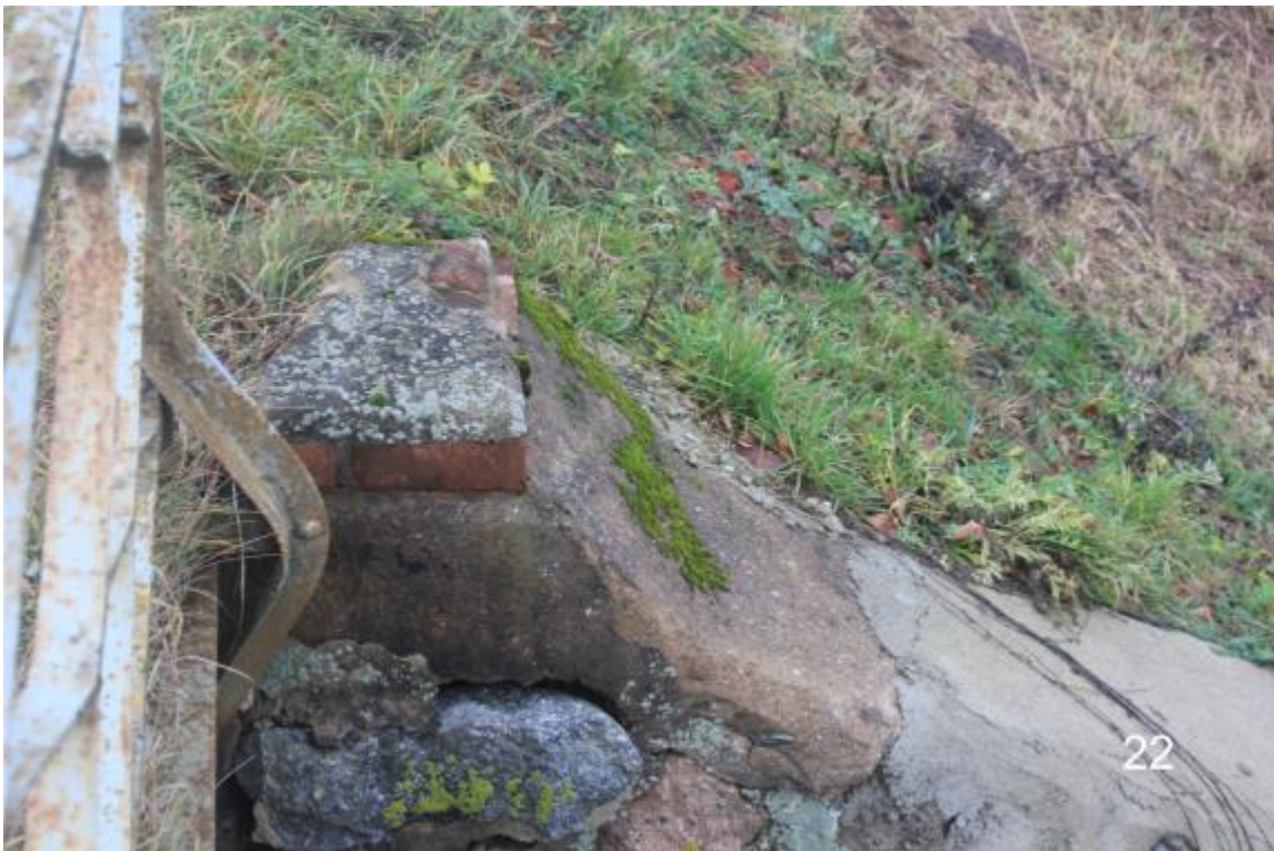
Vydučiaių tilto keturkampio plano raudonų keraminių plytų mūro stulpelių liekanos vaizdas iš Pietryčių pusės,
